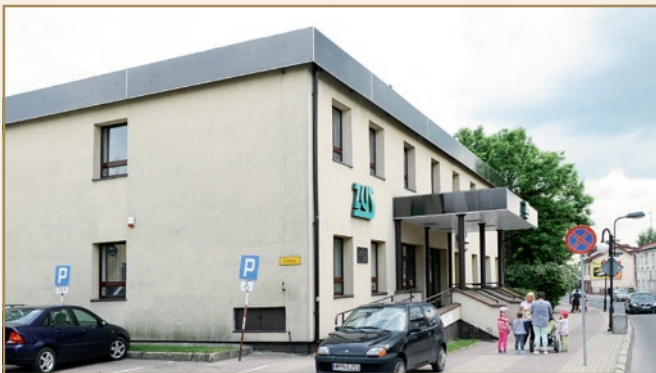
Budynek ZUS przy ul. Warszawskiej, miejsce byłej synagogi, fot. Piotr Koper.
