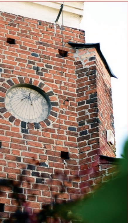
Zegar słoneczny na południowej elewacji kościoła poklasztornego w Płońsku przy ul. Plockiej, fot. P. Koper.
