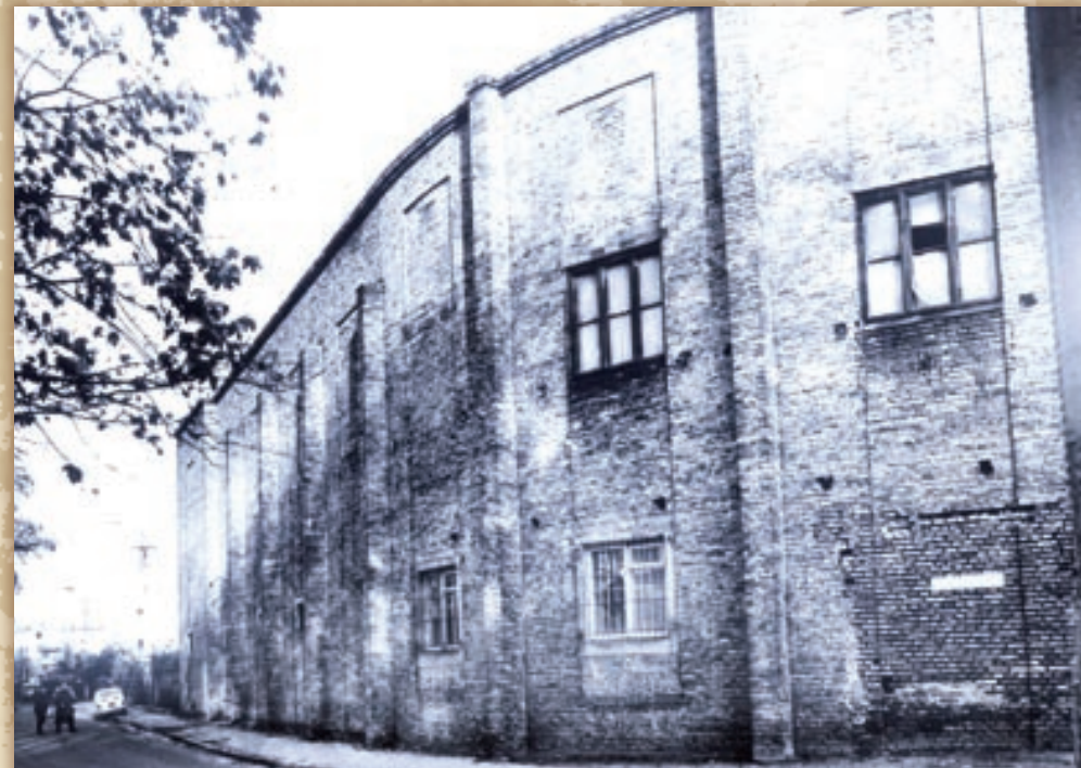
Budynek usytuowany u zbiegu ulic Zduńskiej i Leona Rutkowskiego, wzniesiony w latach 30. XX w. fot. z przełomu lat 70. i 80. XX w. – autor zdjęcia: K. Kowalska, PKZ O/W neg. 229612; fot. nr 89 zamieszczona w: Płońsk. Studium historyczno-urbanistyczne wykonane na zlecenie Wojewódzkiego Konserwatora Zabytków w Ciechanowie. Tom II: Zdjęcia współczesne 1981. Oprac. M. Barbasiewicz. Zdjęcia: Krystyna Kowalska.
