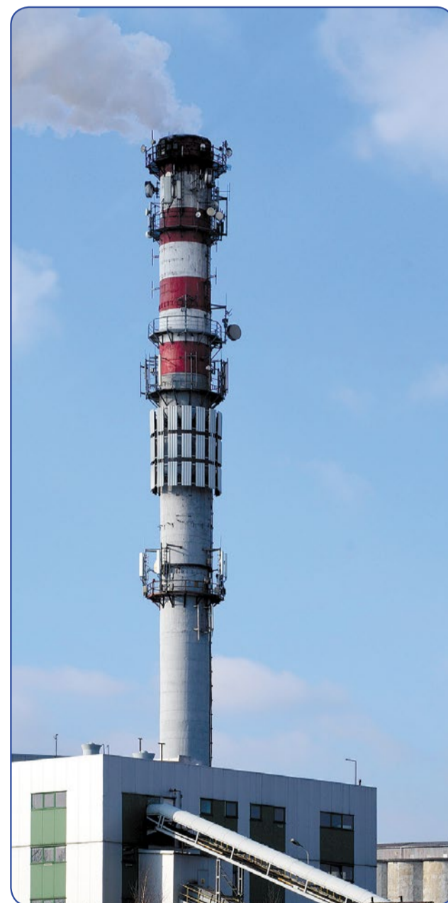
ELEKTROCIĘPŁOWNIA OPALANA BIOMASĄ
